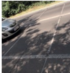
9. sz. ábra: Útburkolatba épített, sebességmeghatározásra is alkalmas piezoelektromos detektorpár (Forgalomszervezés és- irányítás tankönyv, 199. o. Dialóg Campus Kiadó, Budapest, 2019)
